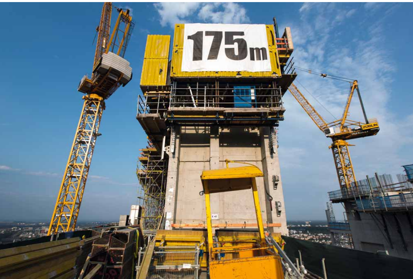
Dvojité kancelárska veža dosiahla v júli 2012 výšku 175 m. Na východnej strane výškovej budovy prebieha montáž rámov na presklenie átria.
